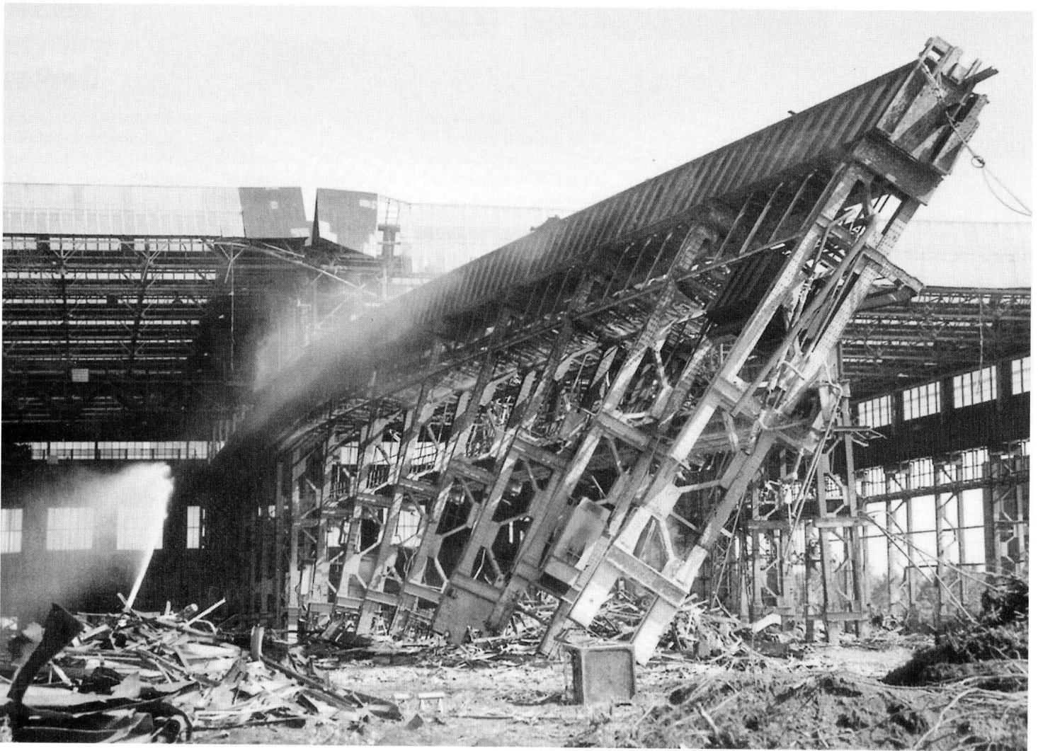
Bild 5. Rückbau des Ständerwerks.
