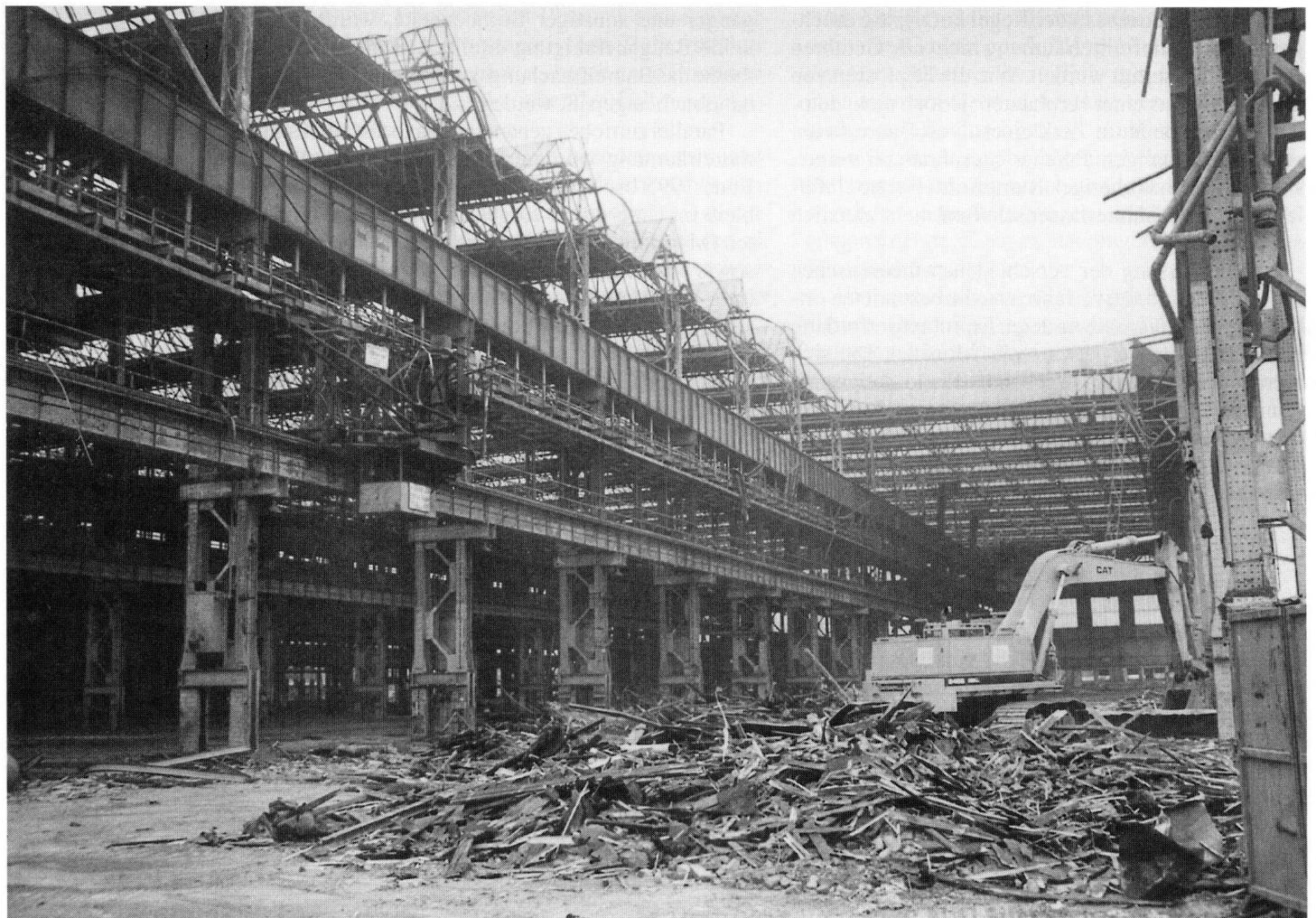
Bild 4. Rückbau entlang der langen Front.
